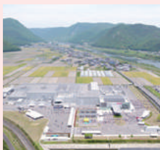
工場でのCO 2 削減。岡山和気工場屋上に設置された太陽光発電
